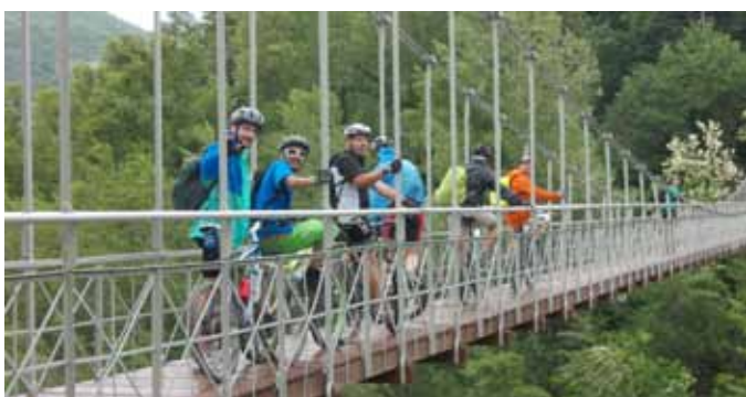
La passerella sul fiume Reno
